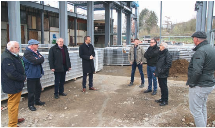
Die drei Geschäftsführer der Falk GmbH bei der Baustellenbegehung mit CDU-Vertretern und dem Bundestagsabgeordneten Josef Oster
